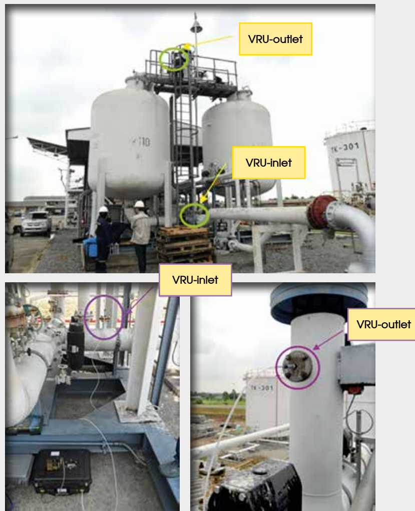
รูปที่ 3-7 การเก็บตัวอย่างไอระเหยน้ำมันเบนซินก่อนและหลังเข้าระบบ VRU ด้วย Tedlar bag : Method 18
